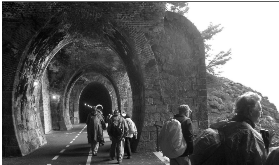
29.4. '12 Seconda galleria ex linea ferroviaria tra Framura verso Bonassola
